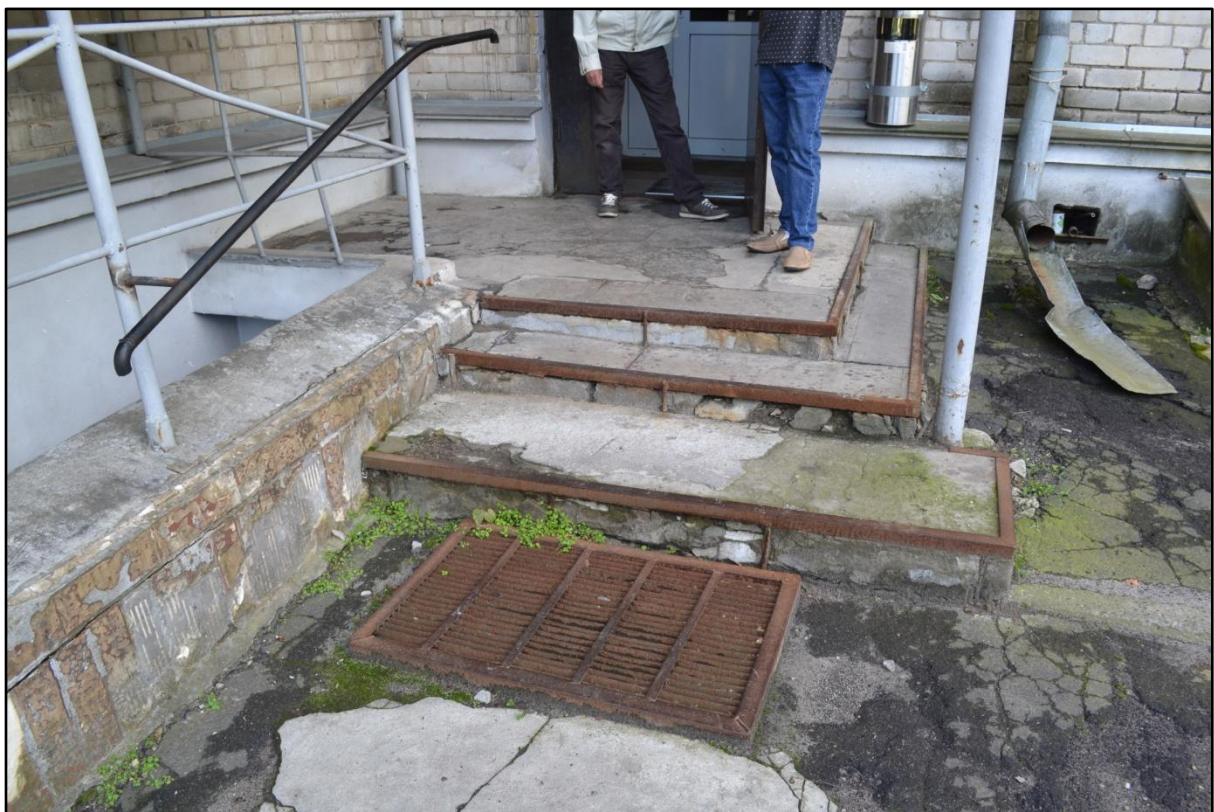
Фото. 1.2. Загальний вигляд ганку допоміжного входу зі сторони внутрішнього двору.
