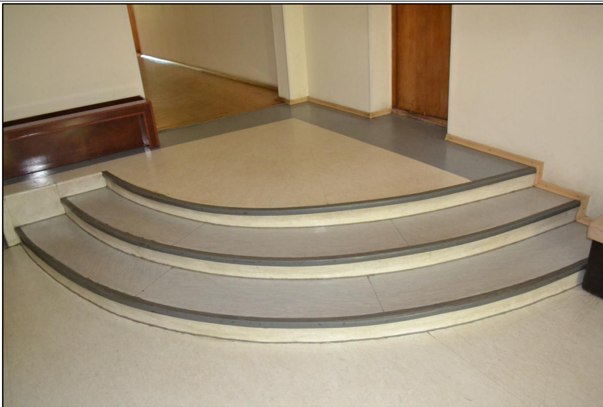
Фото. 1.3. Загальний вигляд влаштованих сходів (головного холу загального користування), на ділянці перепаду висот підлог.
