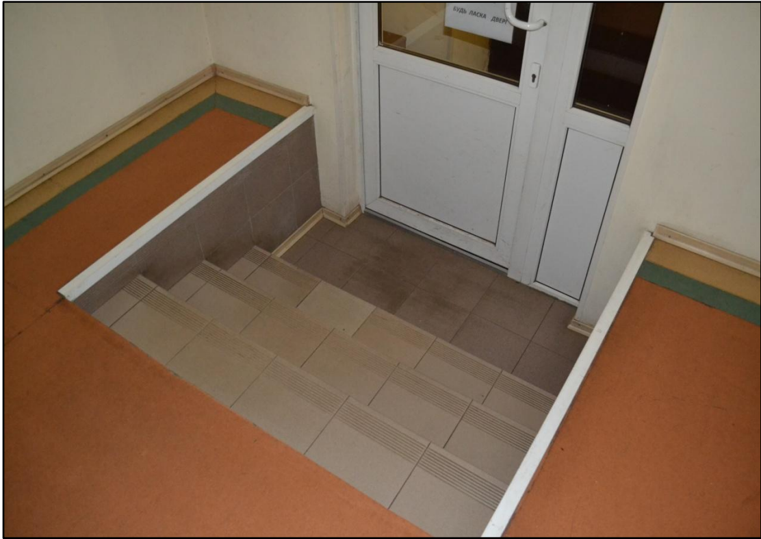
Фото. 1.7. Загальний вигляд влаштованих сходів (холу загального користування), на ділянці перепаду висот підлог другорядної вхідної групи.
